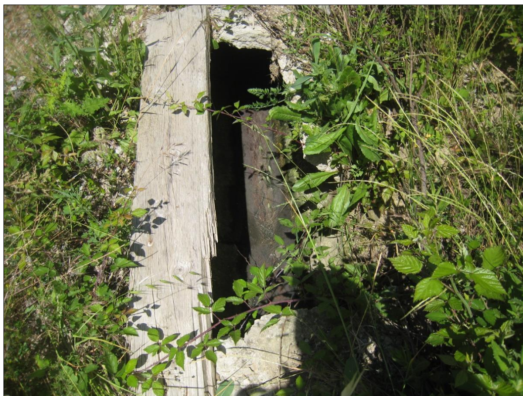
Collettore fognario in calcestruzzo danneggiato a cielo aperto
