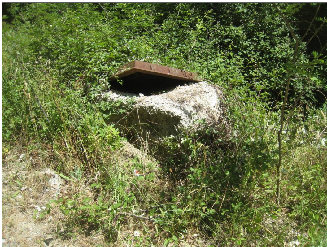
Cameretta collettore fognario in pessimo stato di manutenzione
